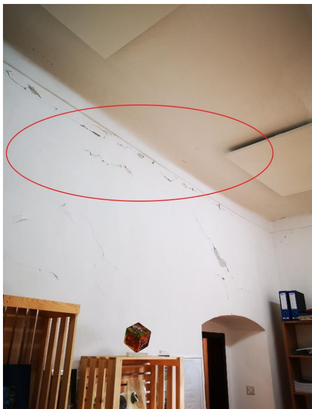
Razpoke na stiku zidu in stropa galerijskega trakta
