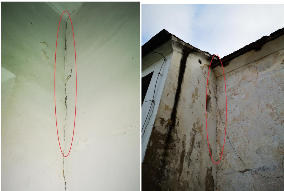
Razpoke v zidu med glavnim objektom in prizidkom stopnišča
